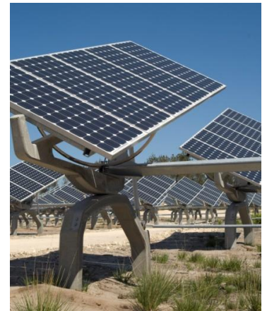
Concept de l'Exotrack : suivre la course du soleil pour augmenter la production électrique d'un parc solaire (jusqu'à 40% de plus qu'une installation fixe idéalement inclinée) tout en respectant le biotope et s'intégrant à l'environnement.
